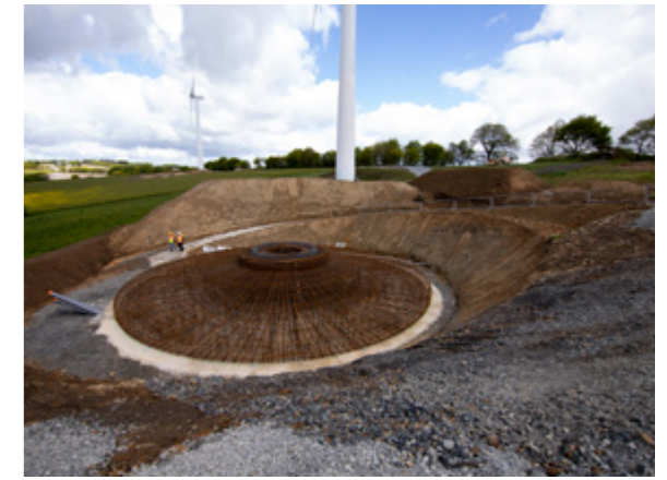
1 ▶ Ferrailage d'une fondation
