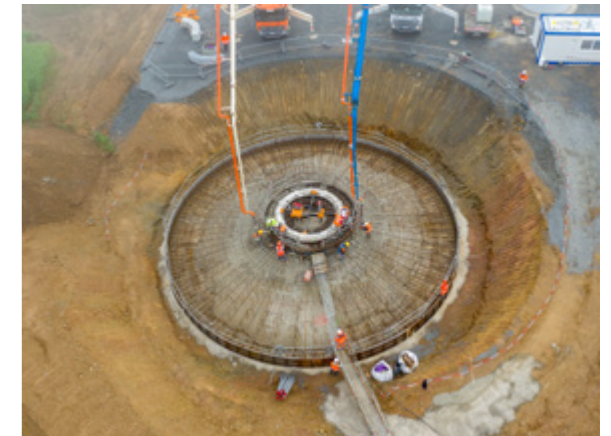
2 ▶ Coulage du béton
